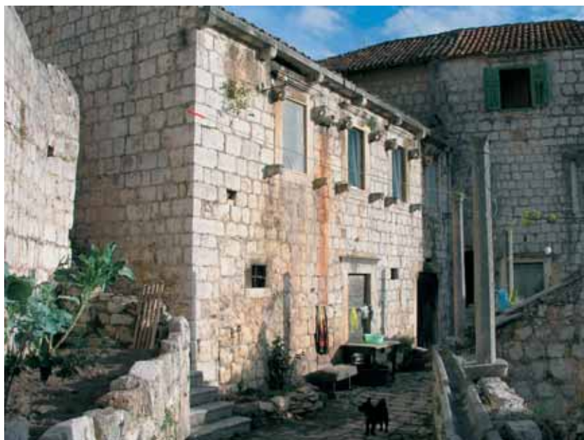
Sl. 3.06 Barokne katnice s ostacima pilona koji su na terasama nosili odrinu
